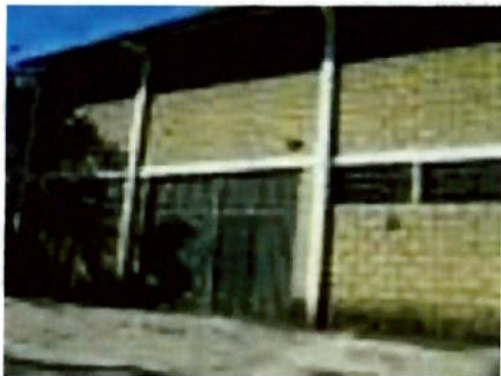
Figura 4: Fechamento da estrutura com alvenaria
